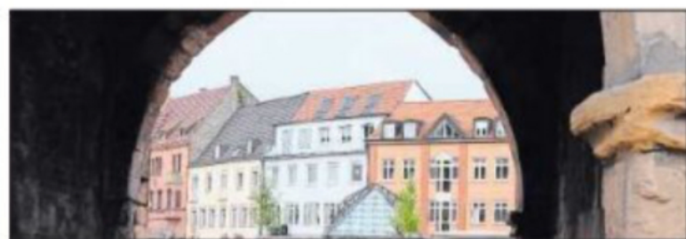
Zweiter Fall: Auf dem Haus mit gelber Fassade will Paul Philipp Schaefer eine PV-Anlage installieren.
